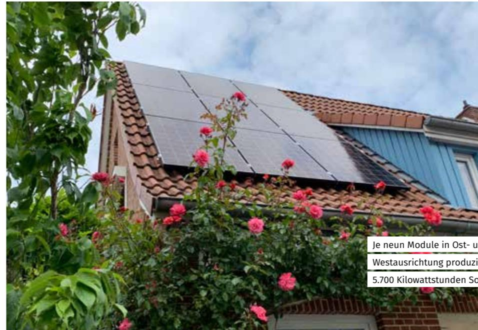
Je neun Module in Ost- und Westausrichtung produzieren rund 5.700 Kilowattstunden Sonnenstrom im Jahr.
